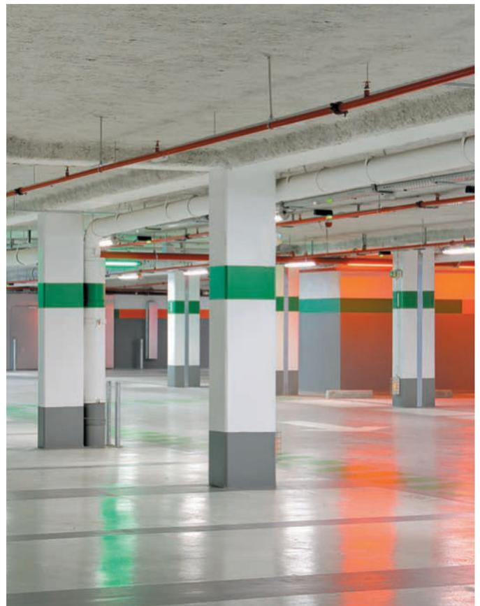
Solution thermique, incendie par Fibrexpan®, finition brut.
