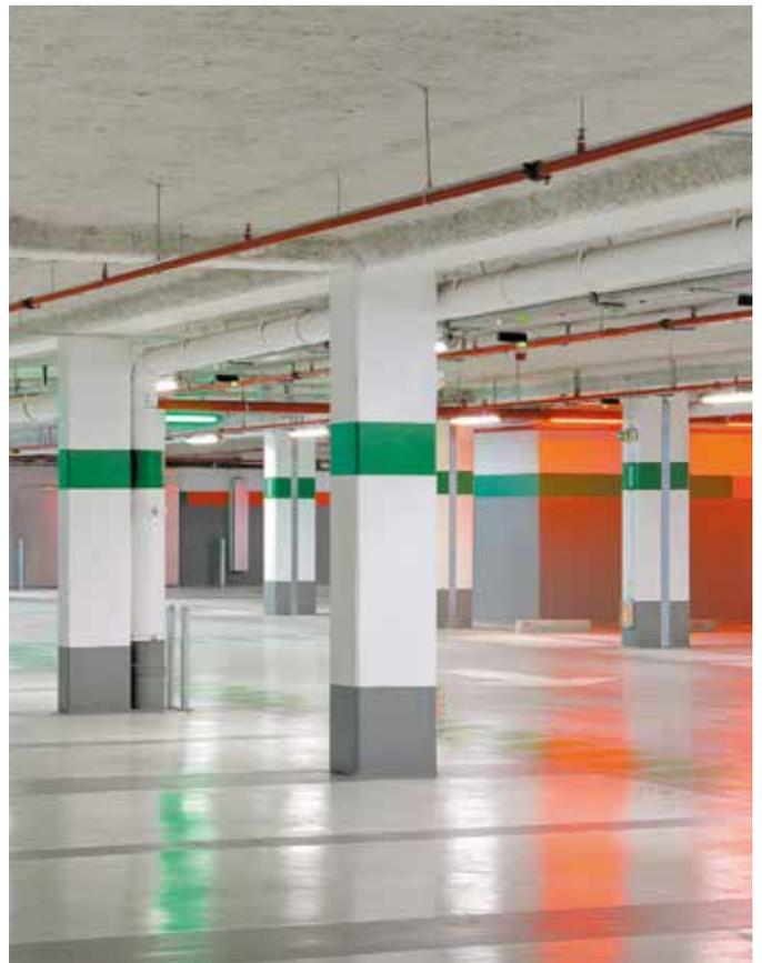
Solution thermique, incendie par Fibrexpan®, finition brut.
