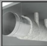
Protection incendie de conduit tôle circulaire de ventilation et de désenfumage horizontal et vertical par Firespray®
