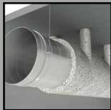
Protección contra incendios de conducto de chapa circular de desahumado horizontal y vertical por Firespray®
